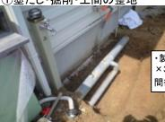
製品寸法(1300mm×600mm×300mm)の墨だしを行い、土間を掘り起こし、填圧する。
