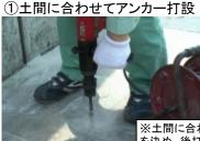
※土間に合わせてアンカー を決め、後打アンカーと全ネジを用意する。
