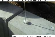
※インサートキャップを 先が4mmのマイナスド ライバーで外す。
