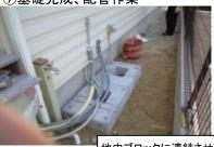
地中ブロックに連結させている全ネジを、基礎上部 面に合わせてカット加工しモルタルを詰める。基礎 ⑧機器設置 開口部にセメント又は土を入れ完成。
