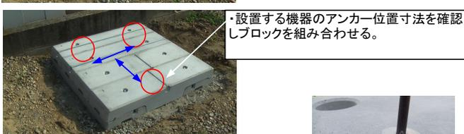
・設置する機器のアンカー位置寸法を確認しブロックを組み合わせる。
