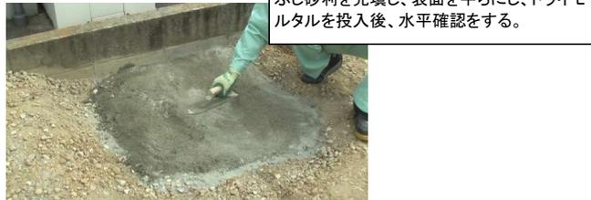
・砂利を敷き、窪み、隙間には砂または目つぶし砂利を充填し、表面を平らにし、ドライモルタルを投入後、水平確認をする。
