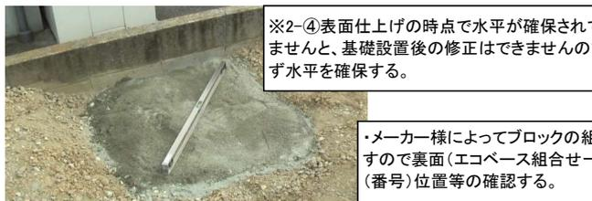
※2-④表面仕上げの時点で水平が確保されていませんと、基礎設置後の修正はできませんので必ず水平を確認する。
