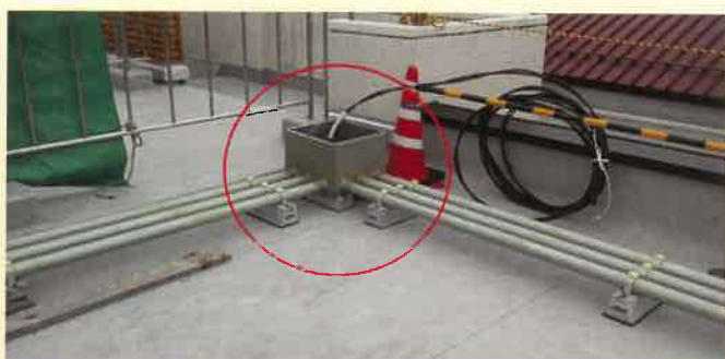
(プルボックスの固定・各種露出配管設備支持)
